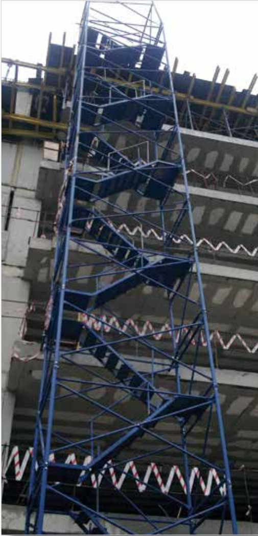
H Çerçevesi Merdivenli İskele H Frame Stair Scaffolding
